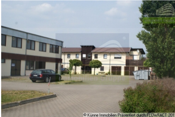
Gewerbehof mit Halle, Büros un
